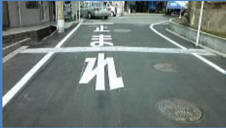
豪雨時の浸水対策に 道路横断側溝を設置
