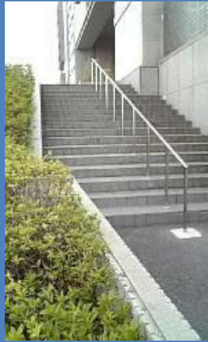
輝きプラザきららに 手すり設置
