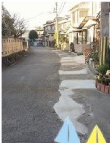
片鉾本町道路補修
